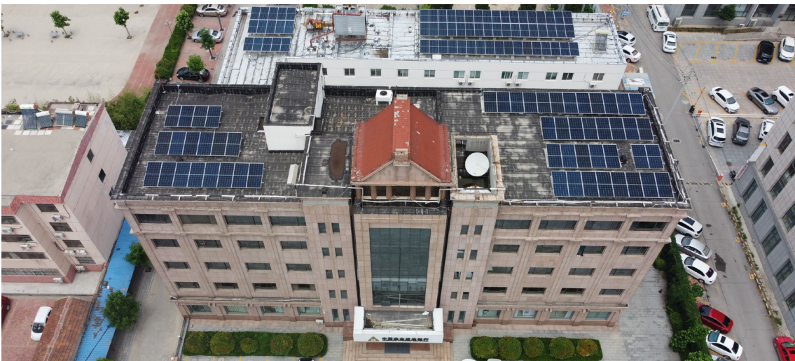
已建成并实现并网发电的光伏屋
